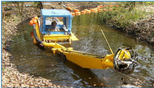
Hydraulisch baggeren met een cutterzuiger
