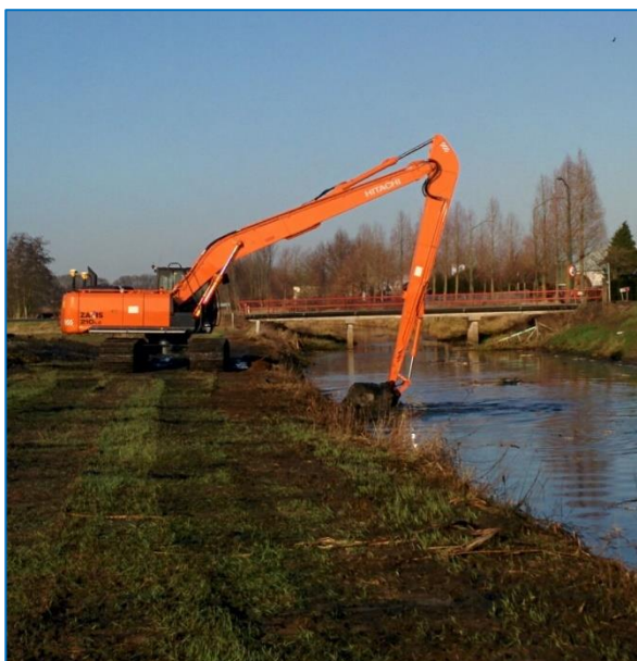
Baggeren met een grijperkraan vanaf de kant
